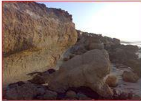
صورة (2) جروف الساحل الجنوبي الغربي النشطة ذو الوجه الحر، ويلاحظ مدى ارتفاعه، وتراجع الجرف وتساقط الكتل الصخرية متباينة الأحجام. التصوير: جهة الجنوب الشرقي.
