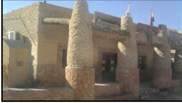
صورة (١) استخدام مادة الكرشيف في بناء فرع بنك القاهرة بمدينة سيوة.
