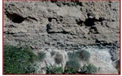
صورة (19) توضح ظهور حفر التافوني في وجه الحافة الشرقية في مناطق الشقوق والفواصل بينما تختفى في قواعدها بسبب نمو النباتات التي قد تحمي قاعدة الحافة من عمليات النحت بفعل الرياح. التصوير صوب الشرق
