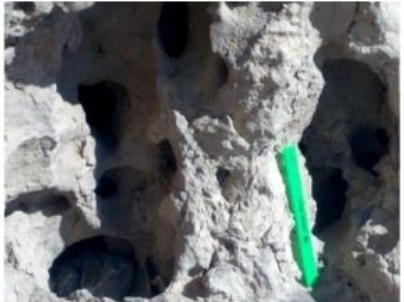
صورة (3) التحام حفر التافوني وتشكيل حفر أكبر حجماً على الحافة الشرقية لنهر النيل شرق المنيا. مرحلة الالتحام التصوير صوب الشرق.
