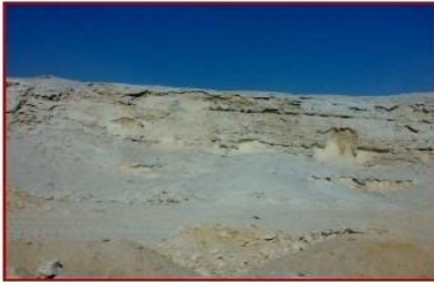
صورة (23) توضح حفر الطريق بمنطقة محاجر المنيا
