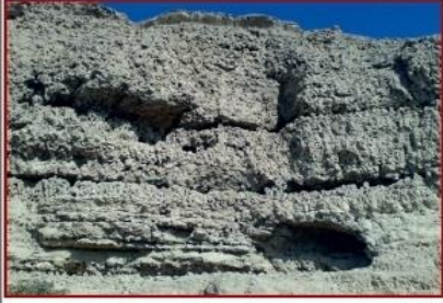
صورة (14) توضح إحدى حفر التافوني الكبيرة غير المسقوفة، كما يلاحظ تشكيلها في مناطق الشقوق والفواصل. التصوير صوب الشرق.
