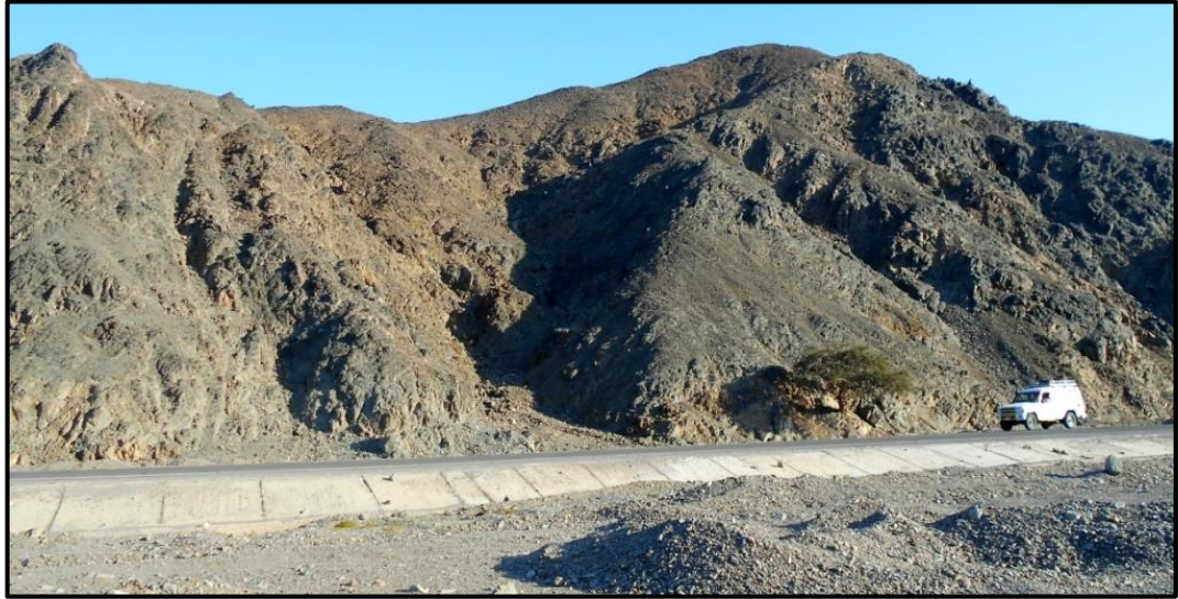
صورة رقم (٦) جزء من طريق مرسى علم - ادفو، ويلاحظ ارتفاع جسر الطريق عن قاع وادي علم بنحو ١,٥ م، كما يلاحظ تكسية الطريق، ناظرًا صوب الشمال.
